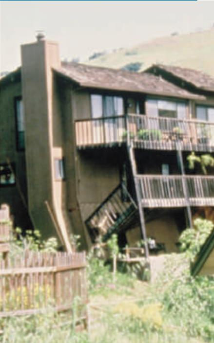
*El balcón de esta casa en ladera se derrumbó parcialmente y ésta se inclinó cuando los postes de apoyo de tipo zancos y las paredes mal arriostradas se desplazaron durante un terremoto.*
