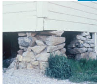
Si su casa está asentada sobre bloques de ladrillo, piedra u hormigón que carecen de refuerzos de acero, los cimientos no podrían soportar los movimientos sísmicos. Su casa podría desprenderse de los cimientos durante un terremoto, dañando las paredes y los pisos, rompiendo las conexiones de servicios públicos y destruyendo lo que hay dentro de su casa. Ésto, a su vez, podría causar incendios, daños de agua y lesiones.
