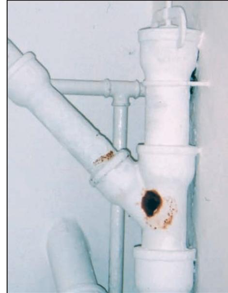
*El orín es indicador de que hay condensación en este tubo de drenaje. Deberá aislarse el tubo para evitar la condensación.*
